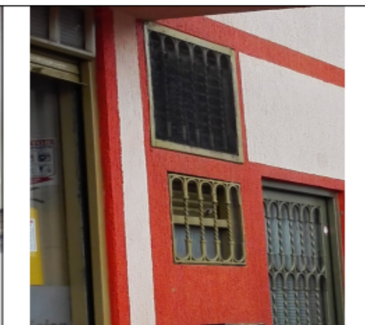
Fotografía No 6. Salida sistema de extracción
